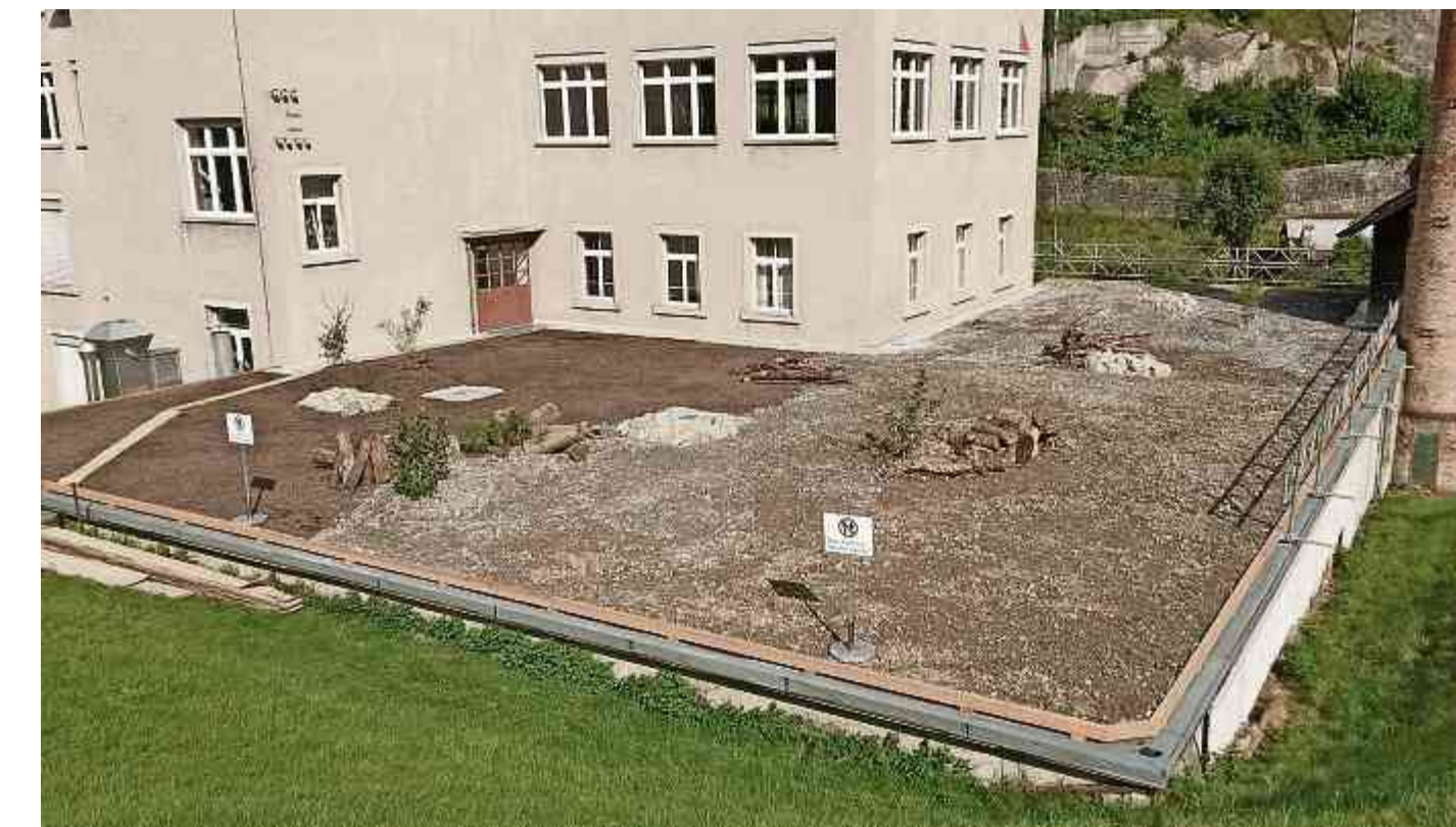
500 m 2 grosse Ausgleichsfläche auf dem Firmendach in Gais: Mit Ast- und Steinhaufen, Büschen und Dachkräutermischung mit 60 Wildblumen. Bild: Kn.
